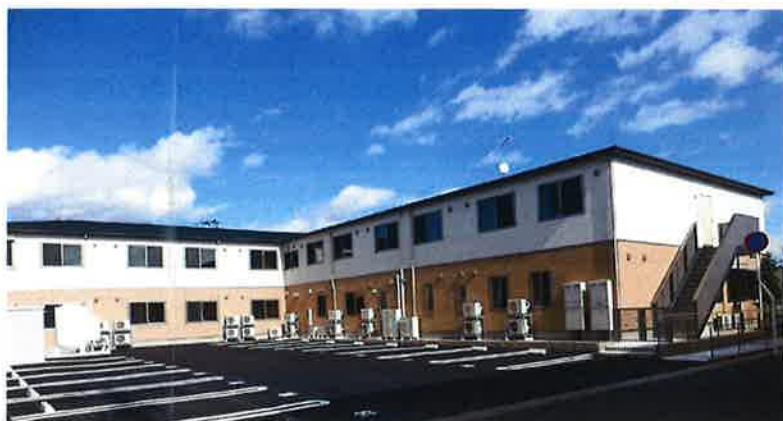
施設を南から西側を望む
