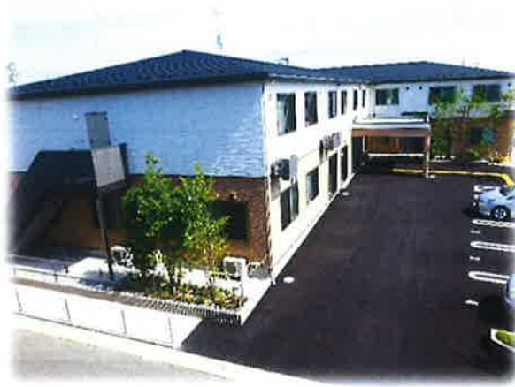
正面を南側から俯瞰
