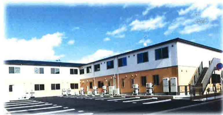
施設を南から西側を望む
